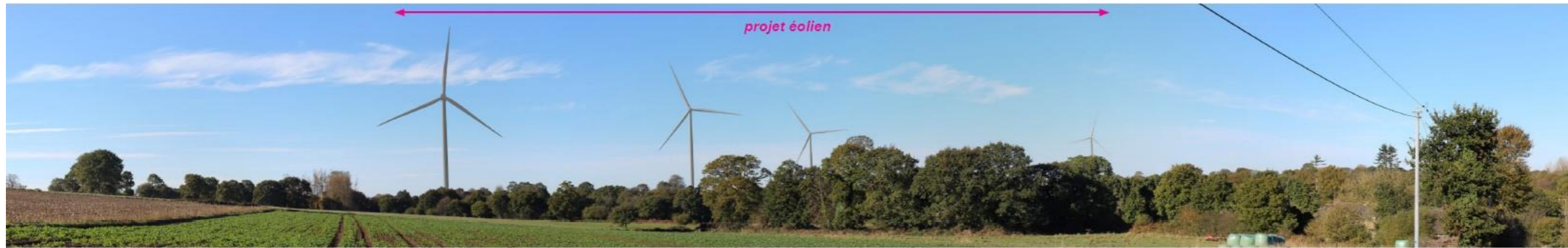
Vue rapprochée sur le projet émergeant au-dessus de la végétation arborée depuis le hameau de Kerfaouen (source : ENCIS Environnement)
